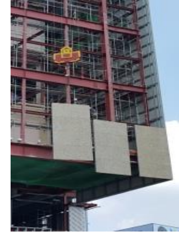
Unit Panel 현장 설치 공정
