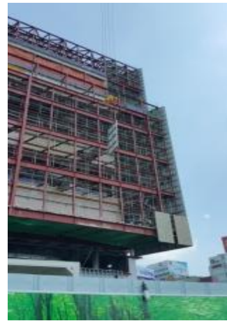
Unit Panel 현장 설치 공정
